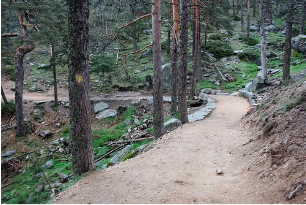
Rehabilitación del Camino Schmidt (Organismo Autónomo Parques Nacionales)
