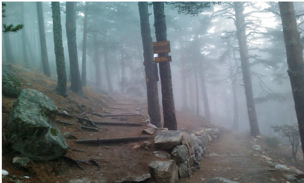
Rehabilitación del Camino Schmidt (Organismo Autónomo Parques Nacionales)
